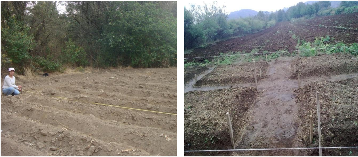
Figura 20. Preparación del terreno.
