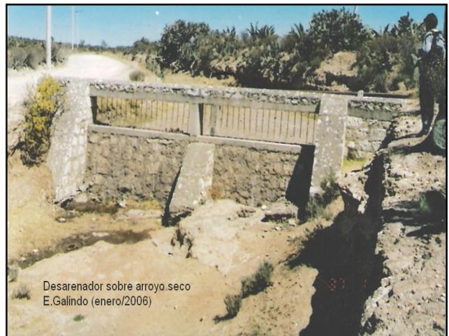
Fotografía 15: Desarenador construido de mampostería sobre el lecho de un arroyo seco
