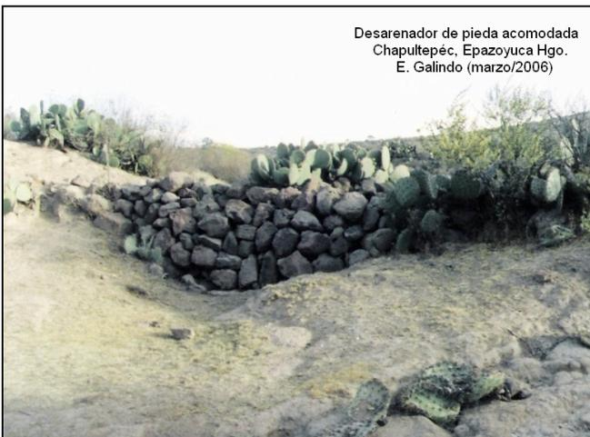
Fotografía 14: Desarenador construido con piedra acomodada sobre el lecho de un arroyo seco
