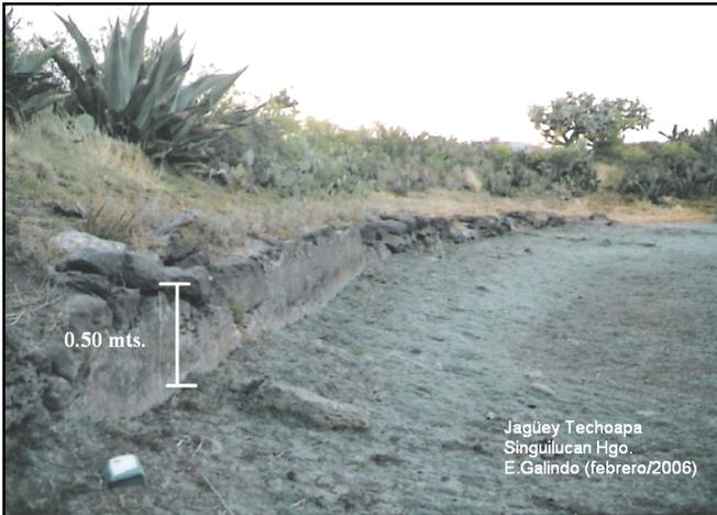
Fotografía 28: Obra de almacenamiento azolvada por falta de mantenimiento
