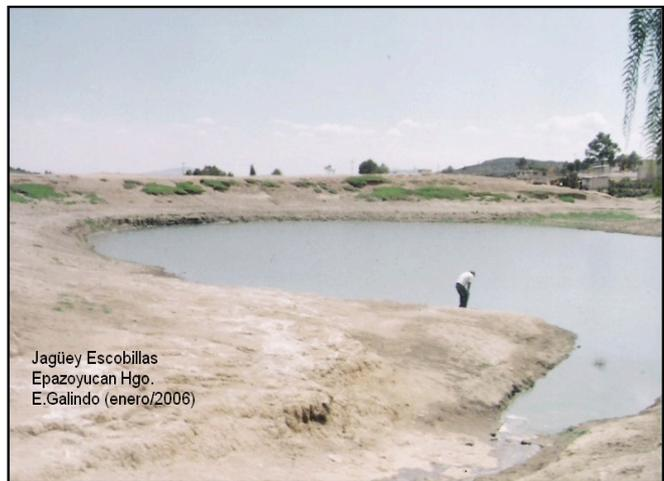
Fotografía 19: Obra de almacenamiento construida únicamente con tierra
