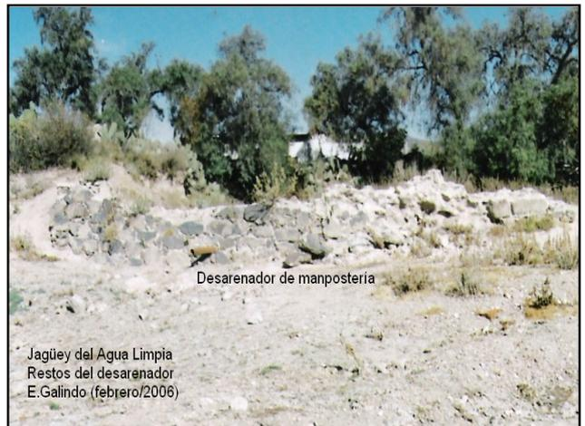
Fotografía 31: Restos del desarenador del jagüey del Agua Limpia
