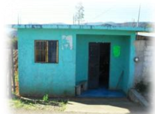
Fotografía No. 46 Construcción de la tienda. Febrero 2010
