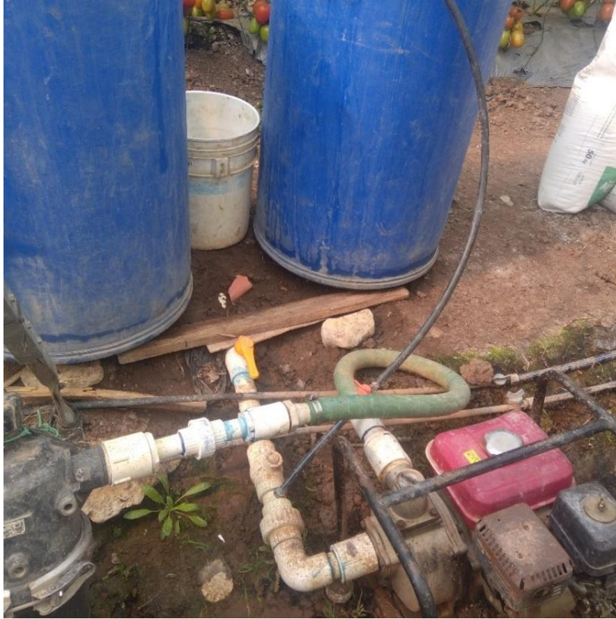
Figura 6. Sistema de inyección de fertilizantes.
