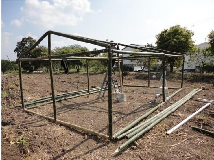
Figura 26. Estructura del secador solar modelo Dos aguas.
