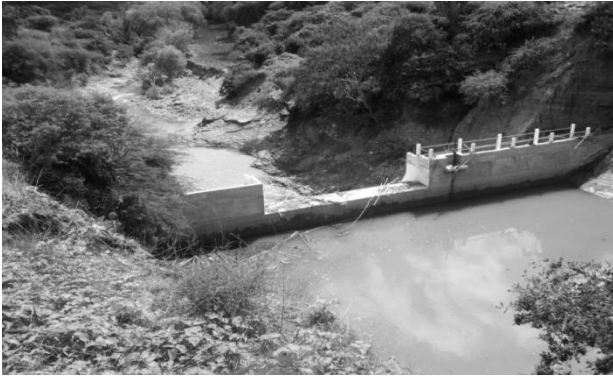
Foto 14. Obras de captación de agua, Presa.
