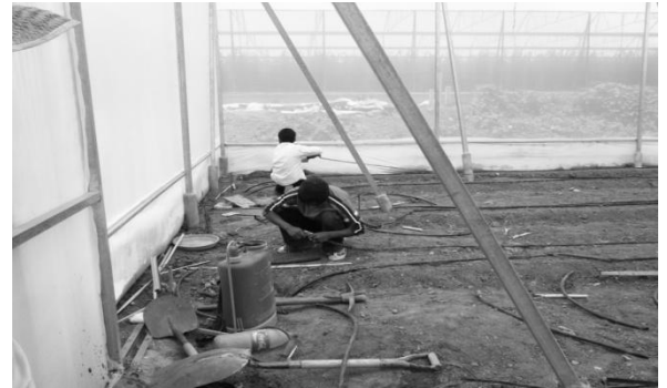
Foto 9. Instalación del sistema de riego y camas de siembra
