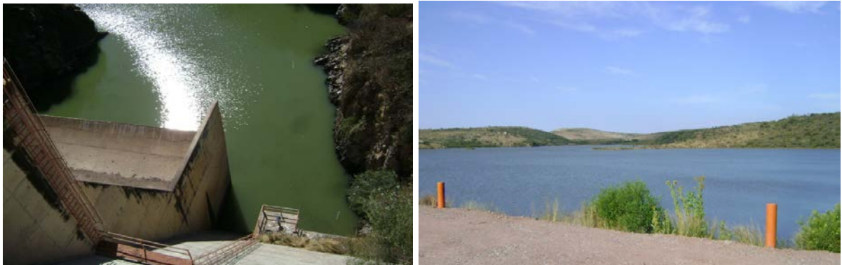
Figura 20. Presa de Almacenamiento Ignacio Allende (Izquierda) e Isidro Orozco Portugal "Neutla", (Derecha).
