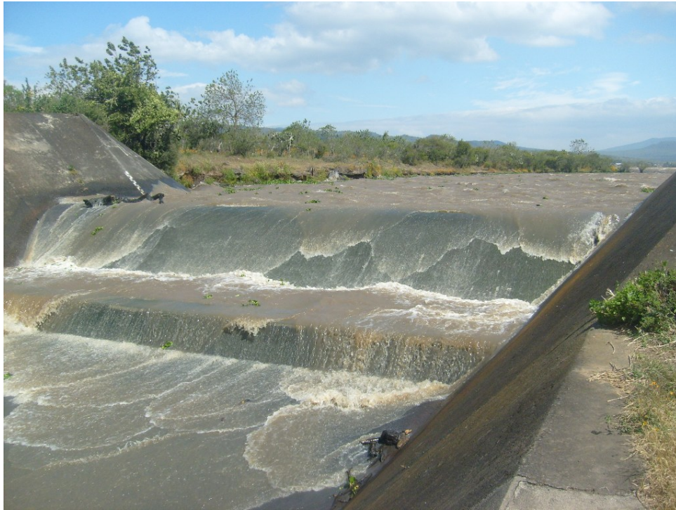
Figura 19. Presa de almacenamiento Urepetiro, del Distrito de Riego 061, Zamora
