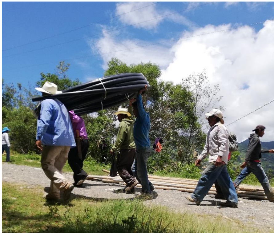
Figura 8. Cambio de tubería. Red de agua de Cerro de las Plumas Fuente: Fotografía propia.
