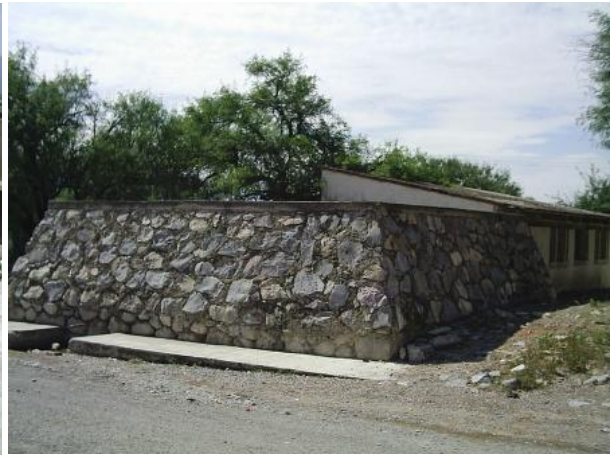
44- Tanque de reserva El Mezquite (Matehuala)
