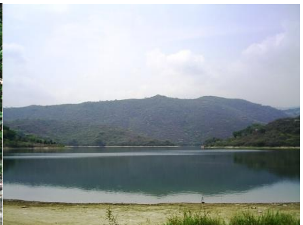
6- Presa de Jalpan de Serra
