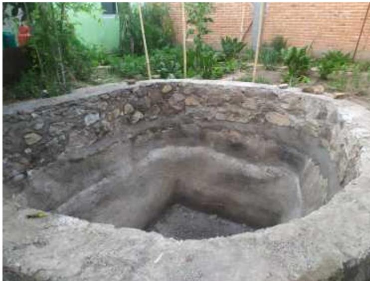
Ilustración 10. Estanque acondicionado con barda perimetral
