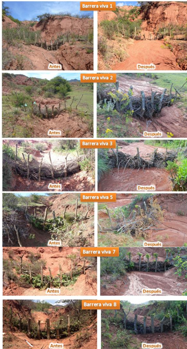
Figura 70. Barreras vivas antes y después de los eventos de lluvia del 2015.
