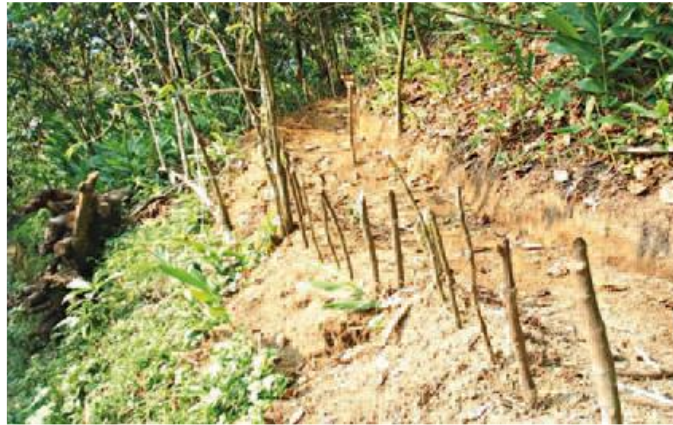
Figura 20. Terraza de muro vivo.
