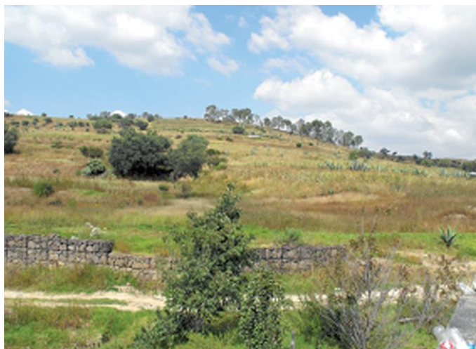
Figura 32. Muro de contención (gaviones y tierra) para retener azolves.
