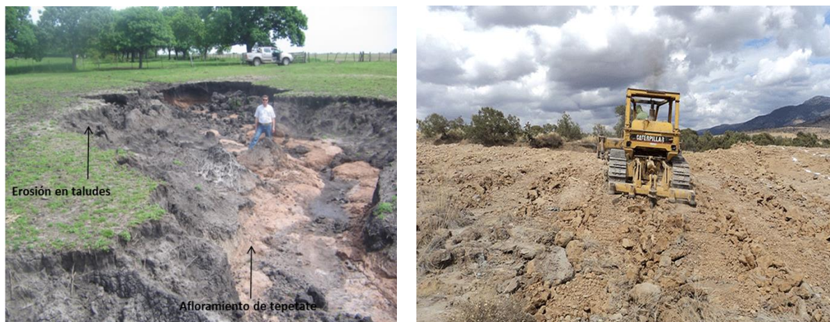
Figura 8. Crecimiento de cárcavas en los taludes hasta el afloramiento del tepetate y roturación de tepetate.
