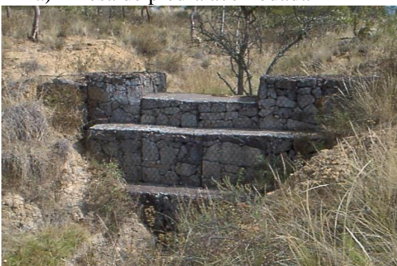
c) Presa de gaviones
