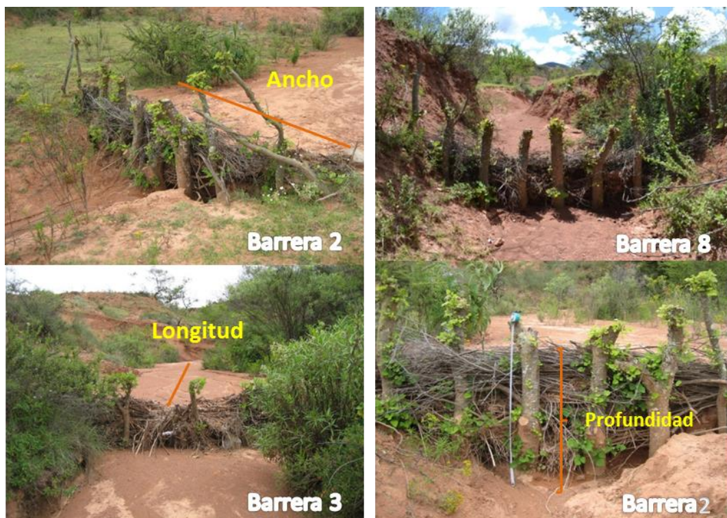
Figura 71. Barreras vivas con ancho, longitud y profundidad de azolves retenidos.
