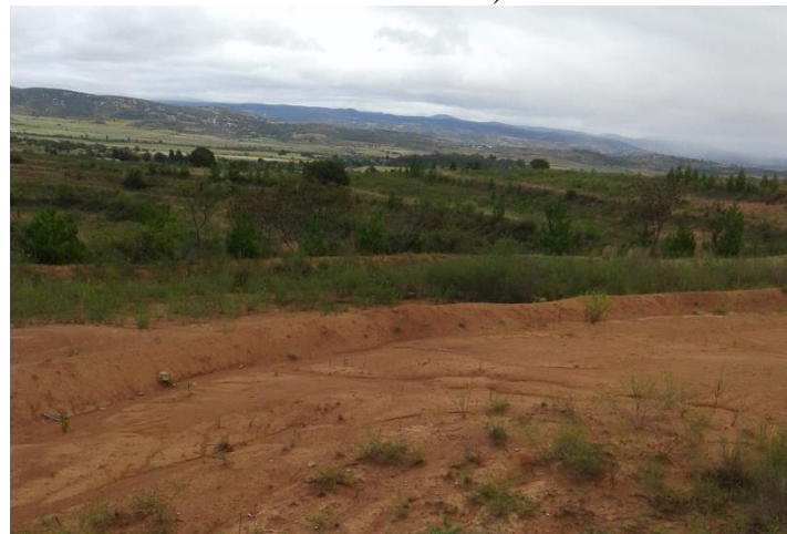
e) Bordo de tierra retención de azolves
