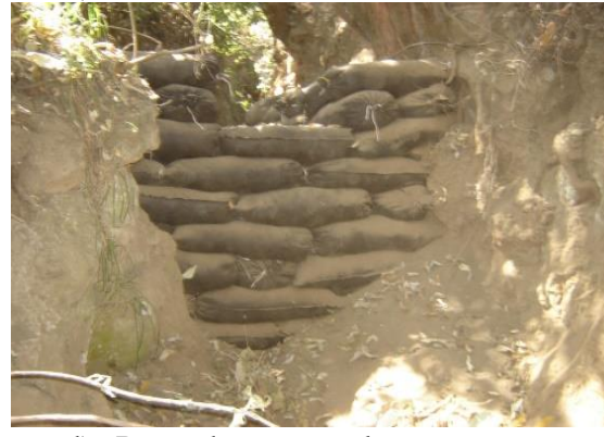
d) Presa de geocostales
