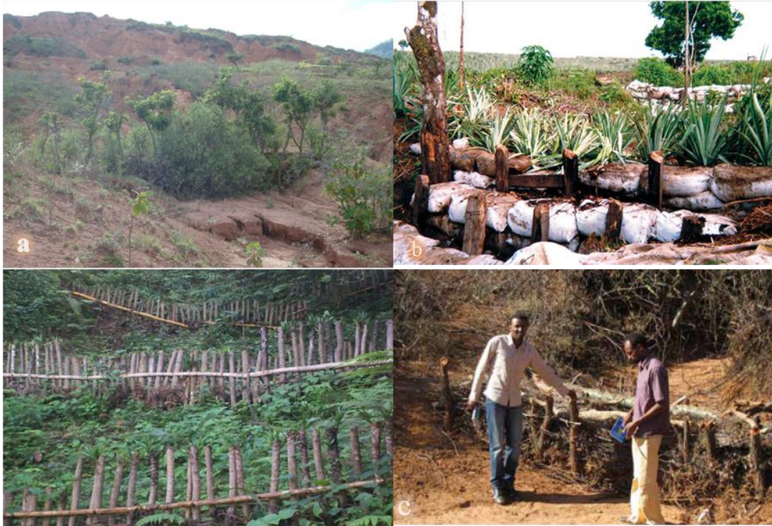
Figura 21. Barreras de especies vegetales (a), Barreras vivas con troncos y costales y tierra (b) y Otras barreras vivas (c).
