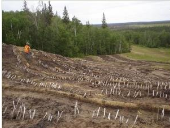
Figura 18. Capas de enramado.
