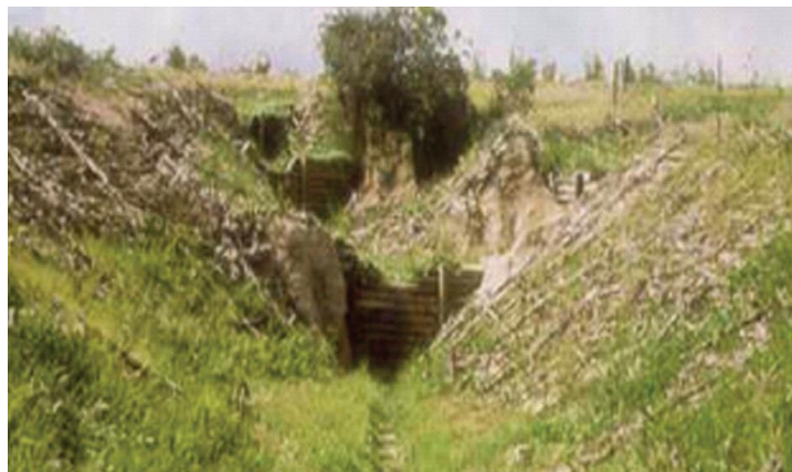
Figura 19. Empastado de taludes
