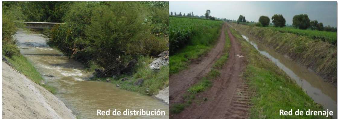
Figura 22 Red de canales y drenes a cielo abierto
