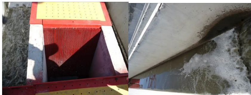
Figura 10. Canal de desarenado
