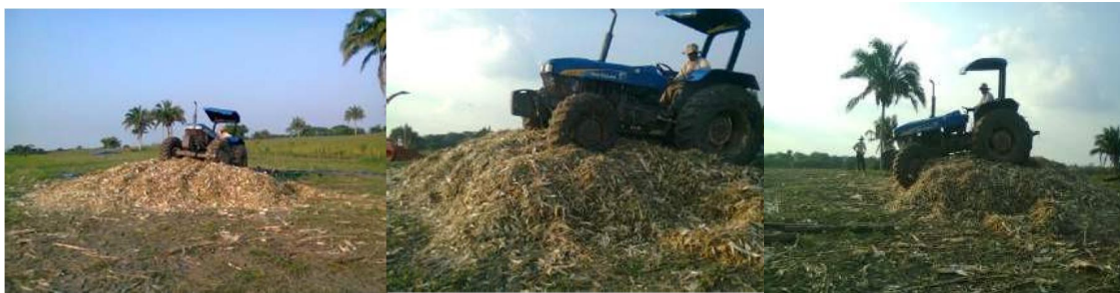
Figura 7. Apisonado para la compactación y extracción de aire.
