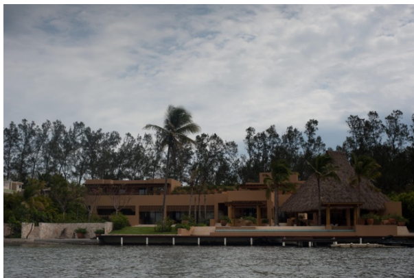
Figura 19. Urbanización en áreas de manglar.
