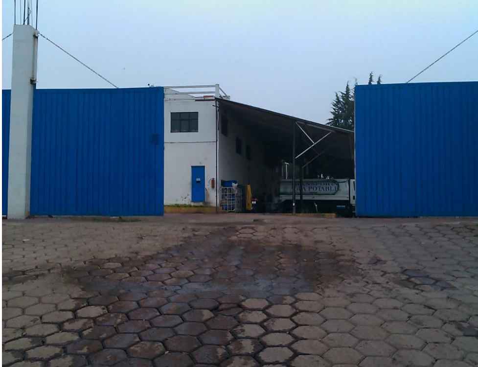
Imagen 54. Acceso principal del pozo Brisas
