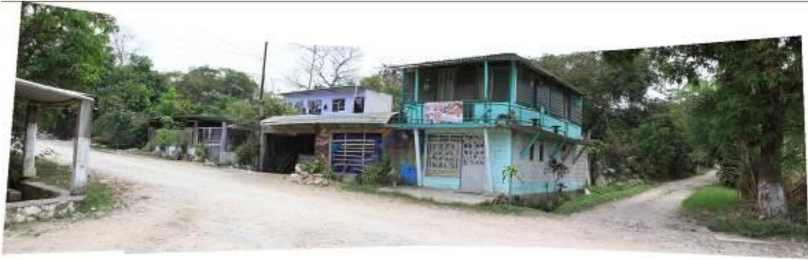
Figura 36. Predio 2. Vista general del predio a intervenir.
