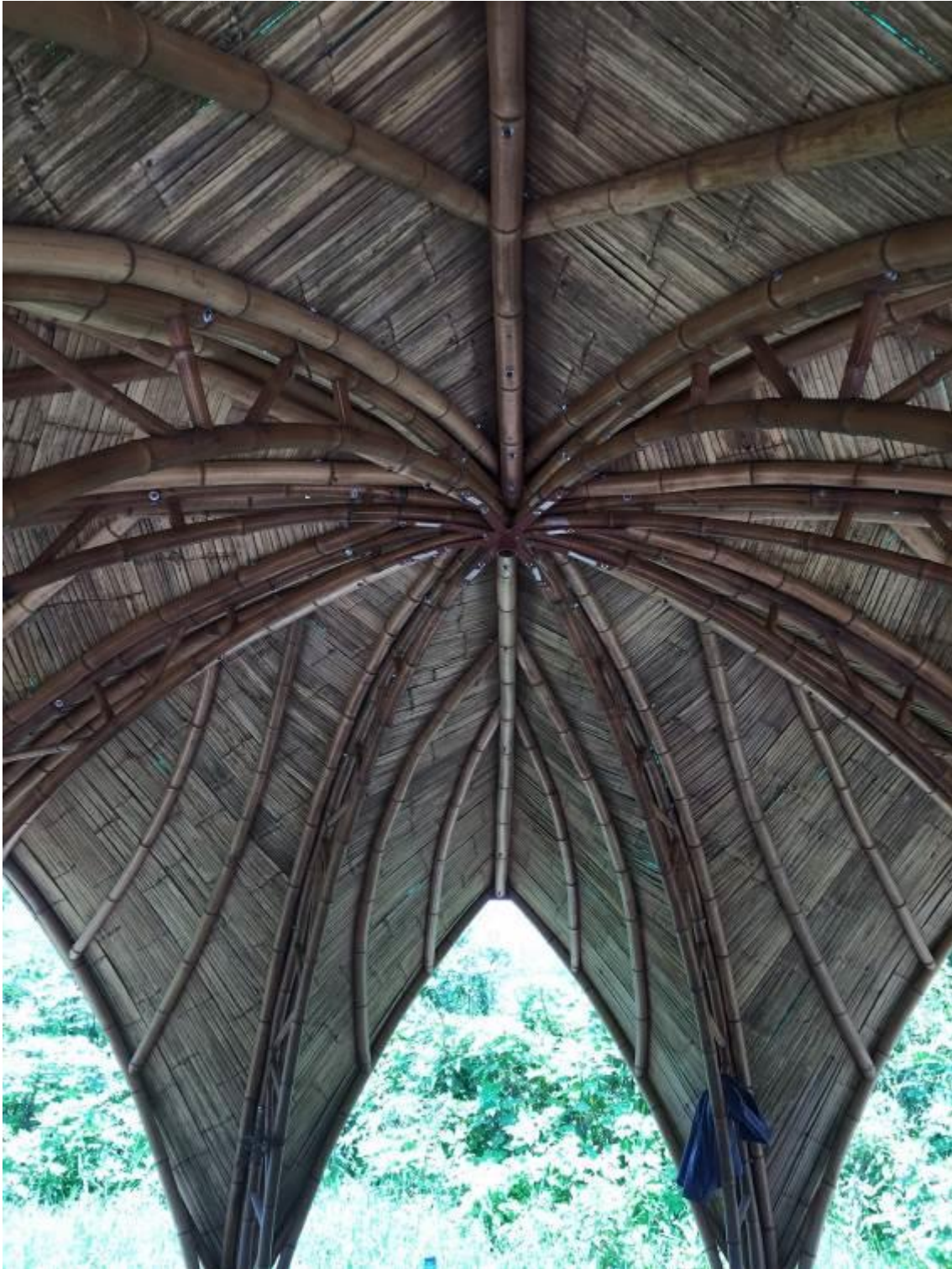
Figura 8. Estructura interior del quiosco.
