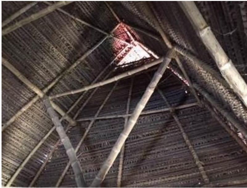
Figura 9. Techo tradicional con estructura de bambú.
