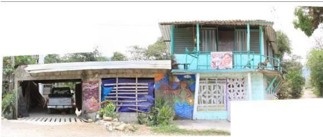
Figura 37. Predio 2. Vista de la fachada principal.
