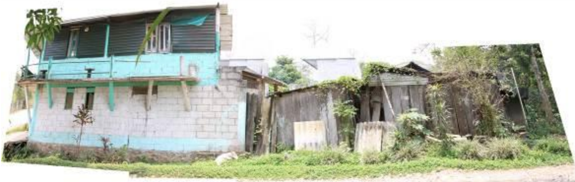
Figura 38. Predio 2. Vista de la fachada lateral.
