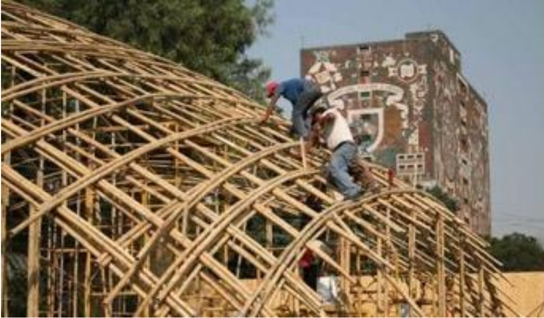
Figura 20. Cascarón reticular en construcción, UNAM.
