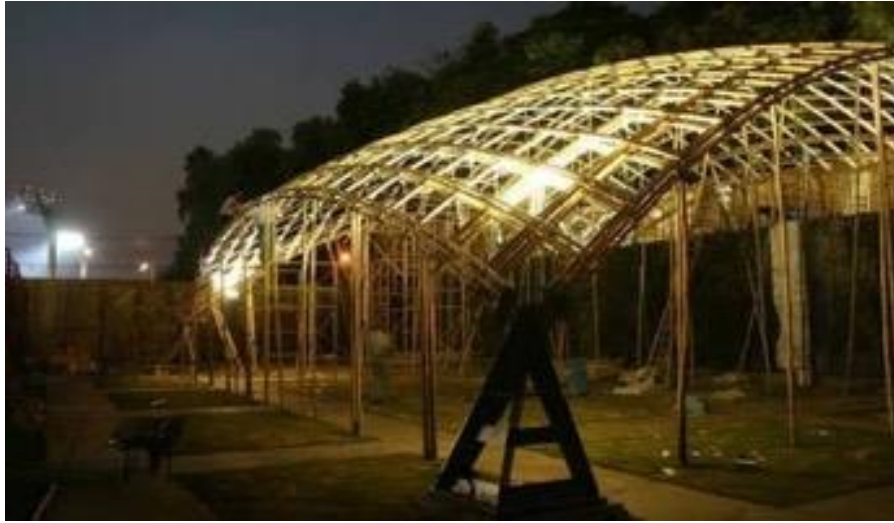
Figura 21. Cascarón reticular en construcción, UNAM.
