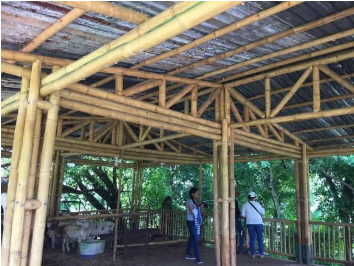
Figura 6. Viga de alma abierta con bambú.
