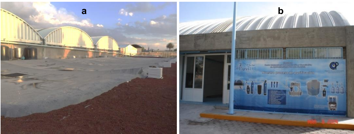
Figura 5. SCALL en el Colegio de Postgraduados, a) Cisterna con cubierta flotante y captadora del agua de lluvia y b) Local de la planta purificadora Lluviatl.
