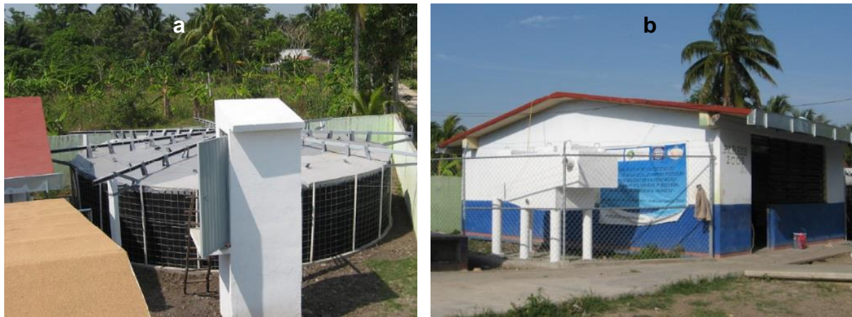
Figura 7. Proyecto comunitario SCALL en la escuela Luis Olive en la comunidad de Las Coloradas, Cárdenas Tabasco, a) Cisterna circular y bombeo solar y b) Canaletas y sedimentador.
