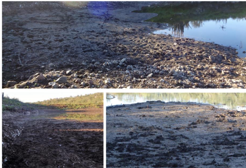
Figura 1.12. Azolve en el bordo Agua Nueva, Miguel Hidalgo, Rioverde, S. L. P.
