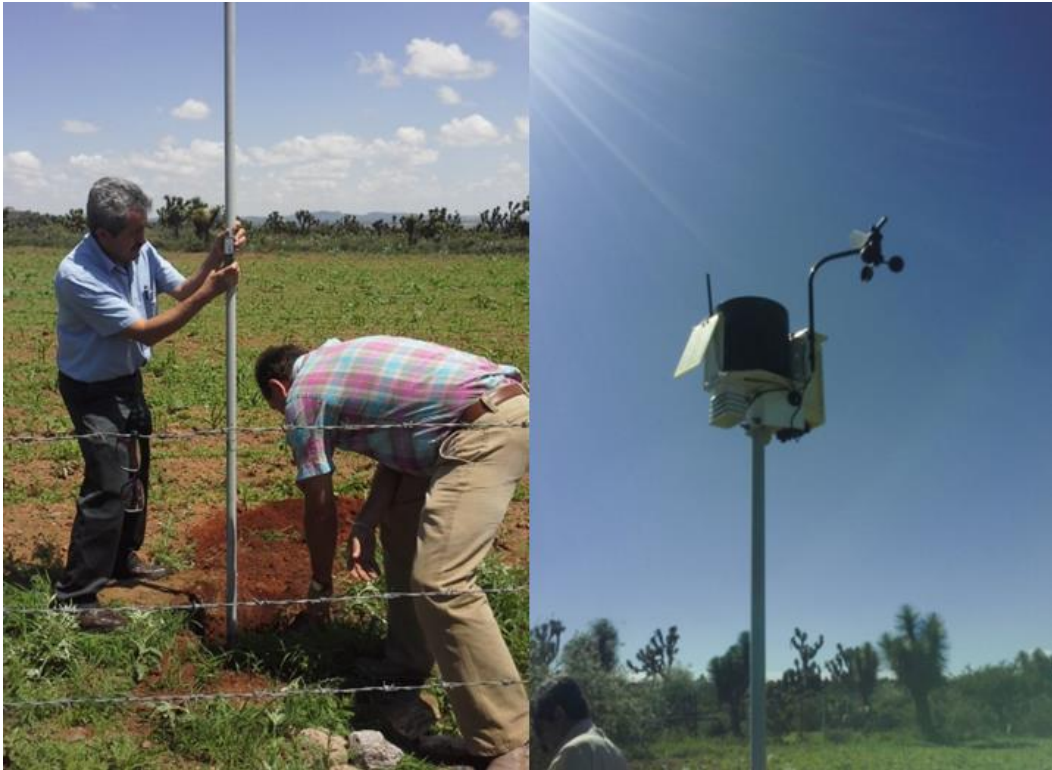
Figura 10. Colocación de la estación meteorológica en la UMA El Milagro, Villa González Ortega, Zacatecas.
