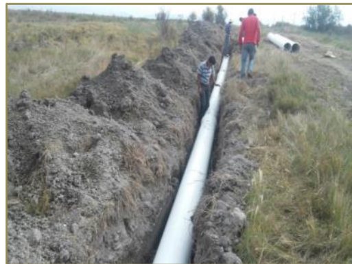
Figura 17. Instalación de tubería.
