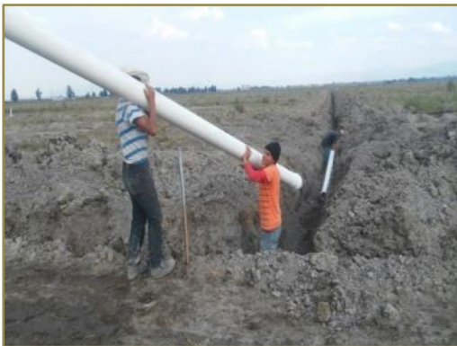
Figura 16. Tendido de tubería.
