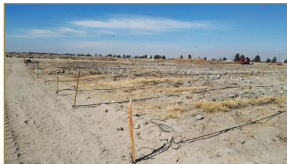
Figura 29. Tendido de manguera.
