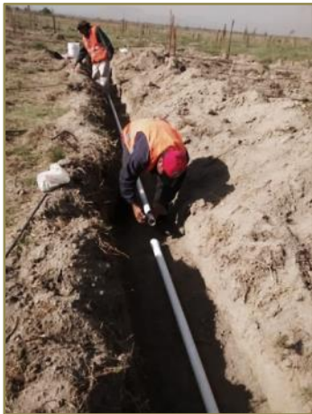
Figura 20. Tendido de tubería de 2”.
