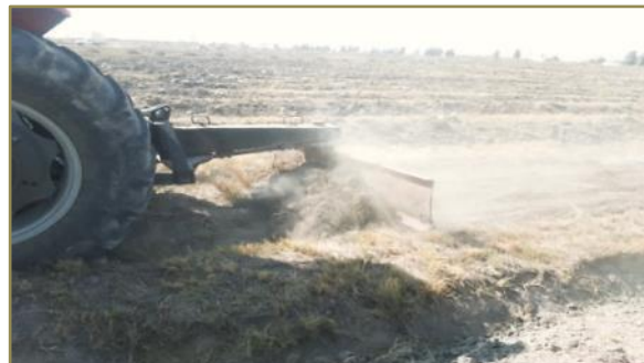
Figura 51. Retiro de cubierta vegetal.
