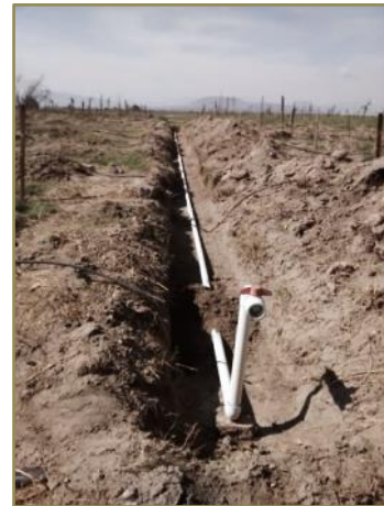
Figura 21. Instalación de tomas.
