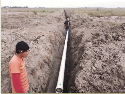
Figura 18. Tendido de tubería de 4”.
