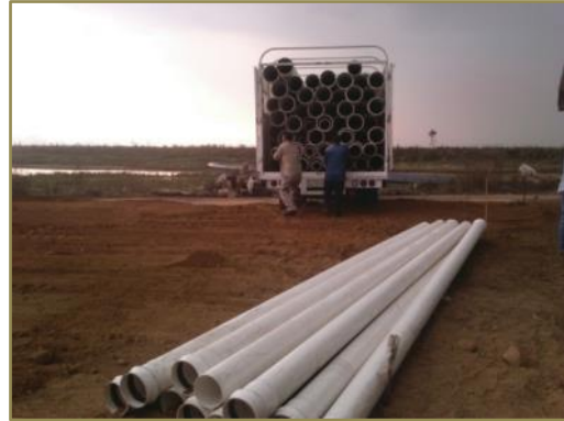
Figura 15. Descarga de tubería de 16”.
