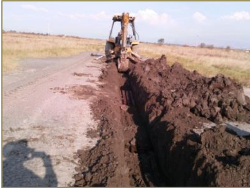
Figura 14. Trazo y excavación para tendido de tubería.
