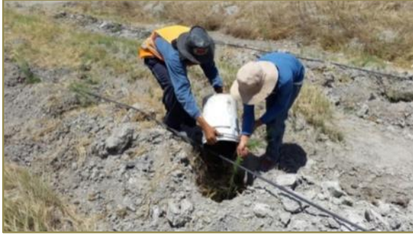
Figura 42. Mejoramiento de suelo.
