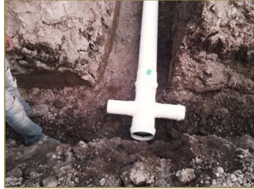
Figura 19. Instalación de cruces.
