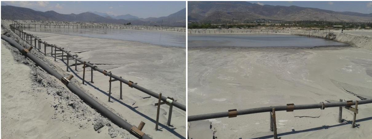
Figura 6 y 7: Línea de conducción de los residuos mineros a las presas de almacenamiento (residuos de minas) en Zimapán, Hidalgo. Fuente propia, tomada el 18 de septiembre del 2014
