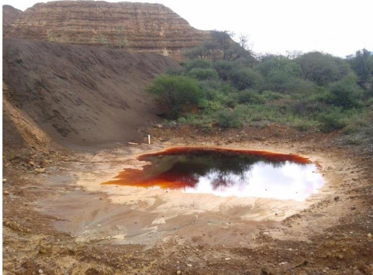
Figura 1: Vista general de un depósito de residuos mineros y acumulación de los lixiviados en la base, antes de incorporarse al cauce de la microcuenca de Zimapán, Hidalgo. Fuente propia, tomada el 18 de septiembre del 2014.
