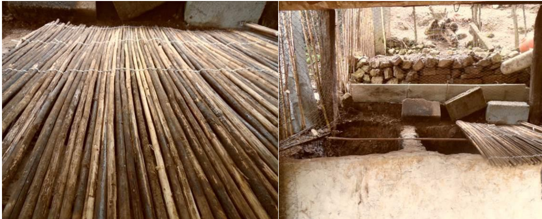
Figura 16. Varitas de shoto acomodadas como cubierta del horno y horno en construcción, julio 2014.
