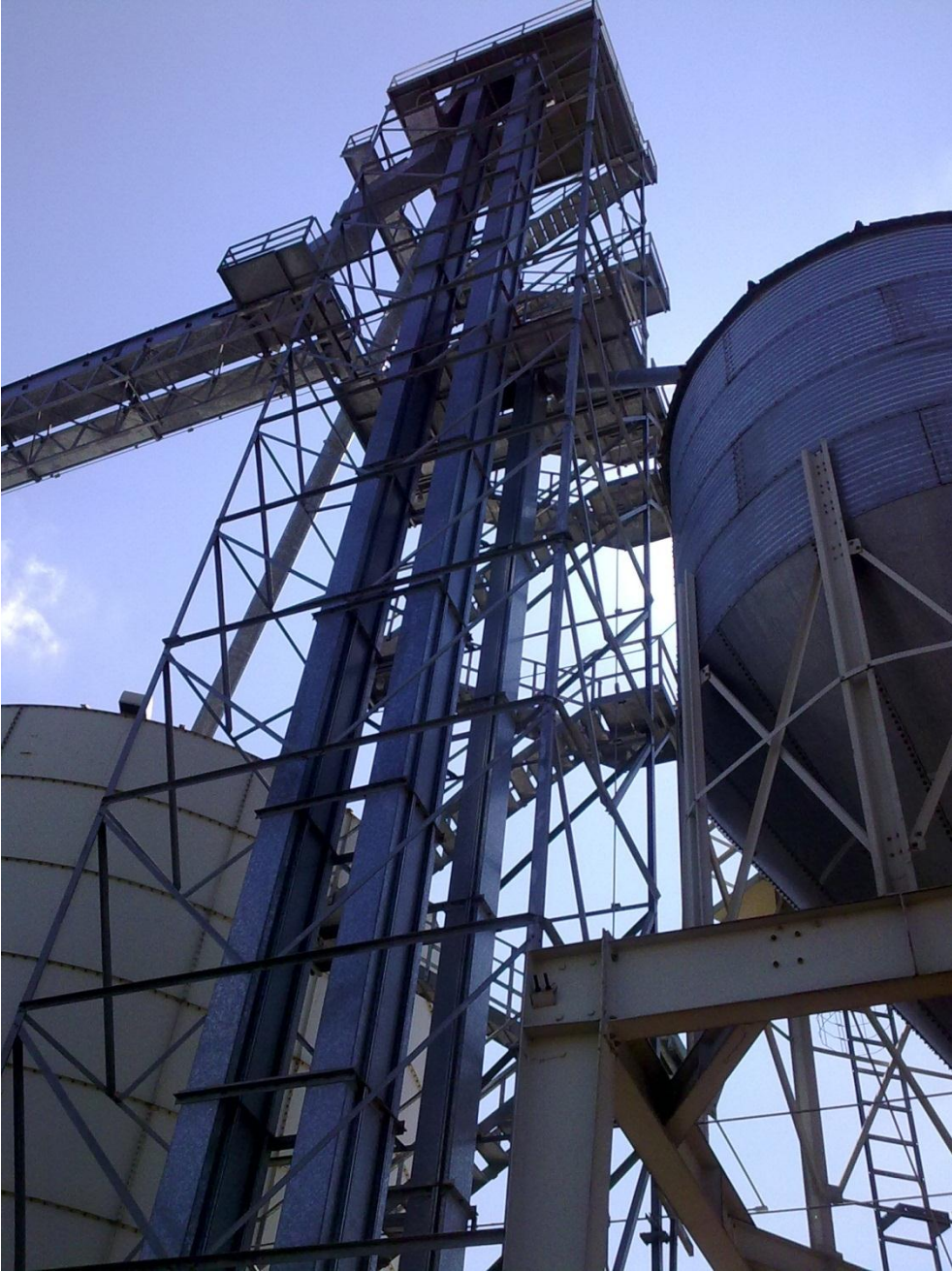
Figura 9. Silos en operación en septiembre de 2011
