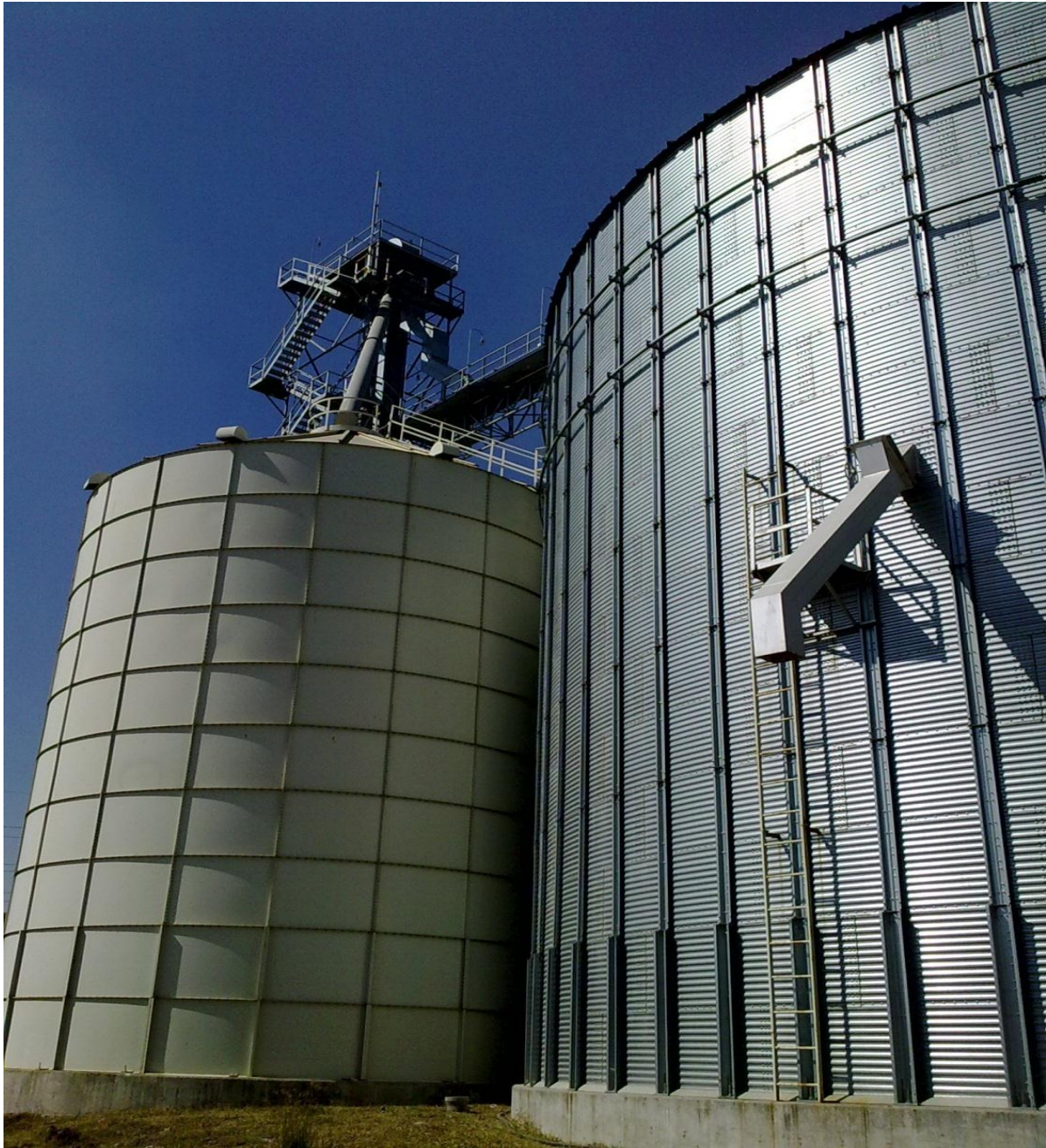
Figura 8. Silos de la URPJ ubicados en El Salto, Jalisco
