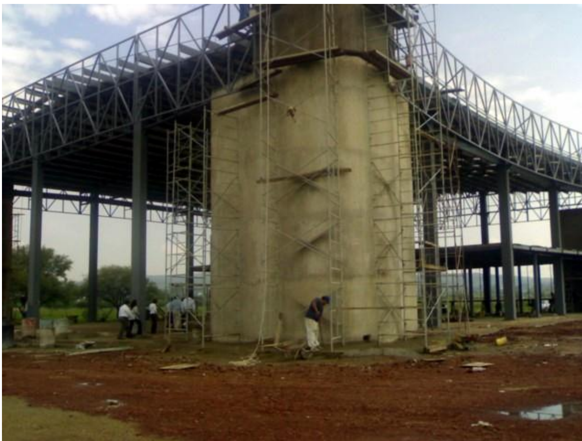
Figura 10. Oficinas de la URPJ en construcción en el 2008
