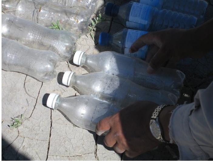
Figura 13. Pegado de botellas para cubrir la superficie de la olla de captación.
