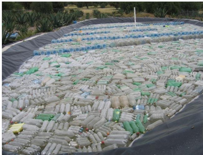
Figura 31. Olla de captación cubierta con las botellas de pet reutilizadas.
