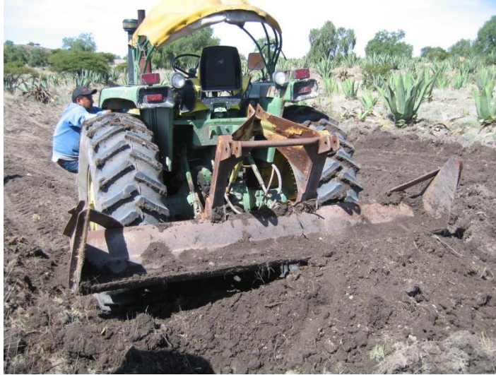
Figura 3. Remoción de la tierra para formar la olla.
