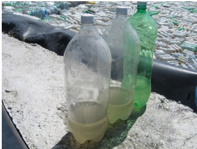
Figura 14. Semi-llenado de las botellas pegadas previamente.
