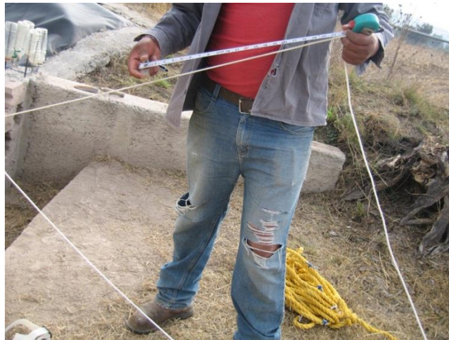
Figura 19. Marcado del cordel.
