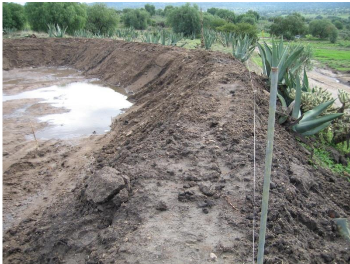
Figura 4. Nivelado de los bordos.
