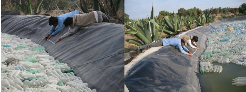
Figuras 17 y 18. Marcado de los costados de la olla para la medición de la profundidad.
