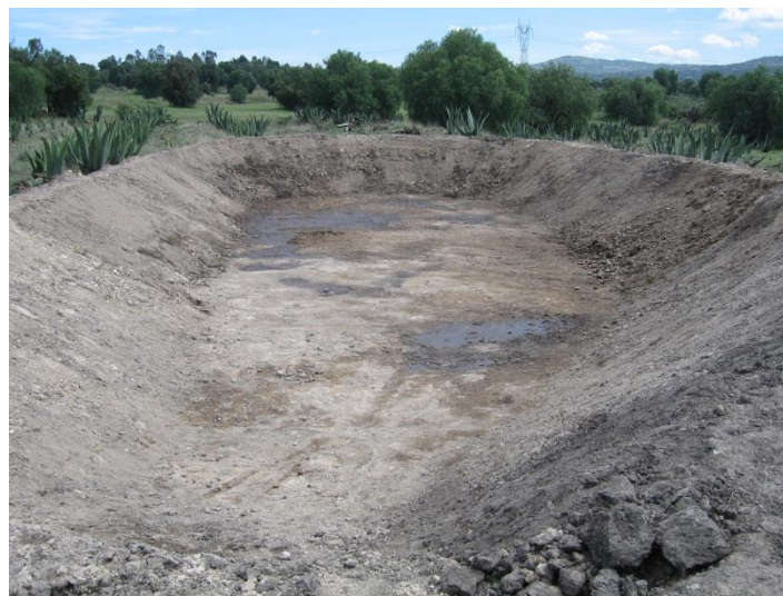
Figura 7. Olla de captación ya terminada.
