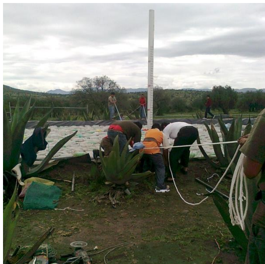
Figura 16. Inmersión del tubo fabricado para medir el tirante del agua contenida en la olla.
