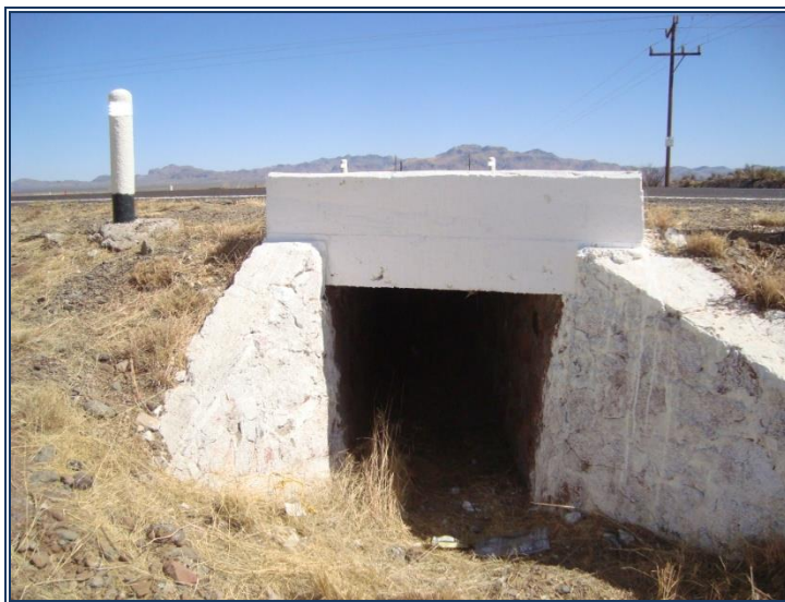
Figura 10. Estructuras de Cruce en el Módulo de Riego 1 El Carmen, Chihuahua.
