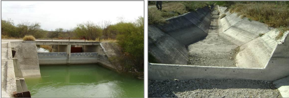
Figura 11. Estructuras de Protección en el Distrito de Riego 004 Don Martín.
