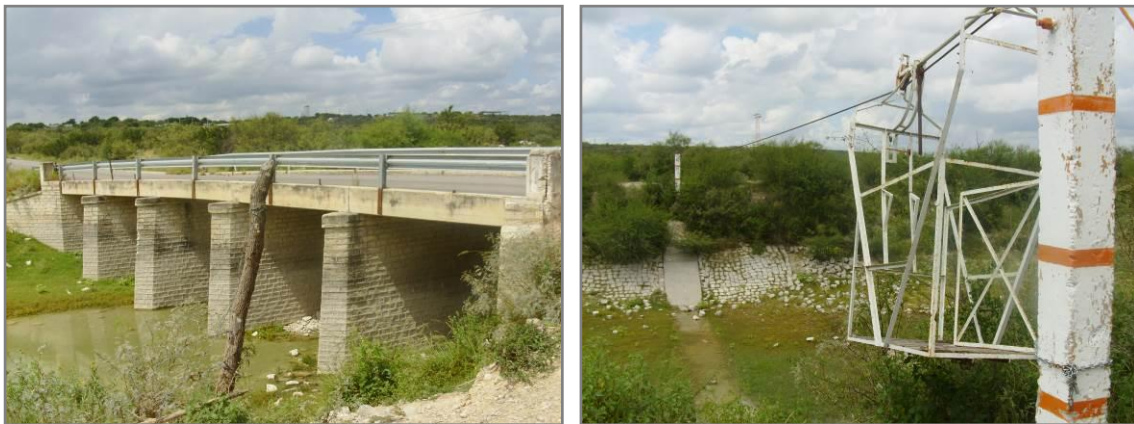
Figura 12 . Estructuras de cruce en el Distrito de Riego 004 Don Martín.
