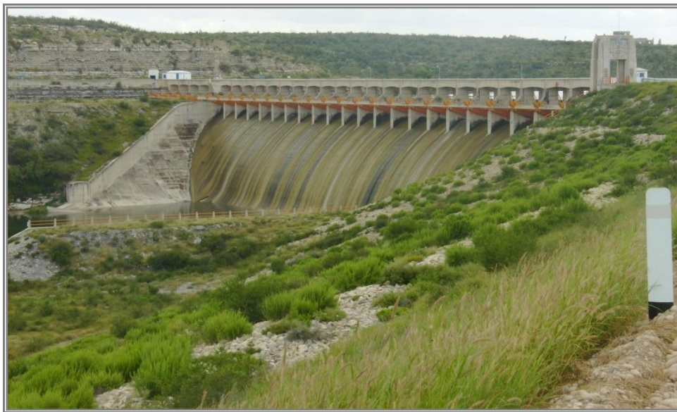
Figura 6. Vertedor de la presa Venustiano Carranza.
