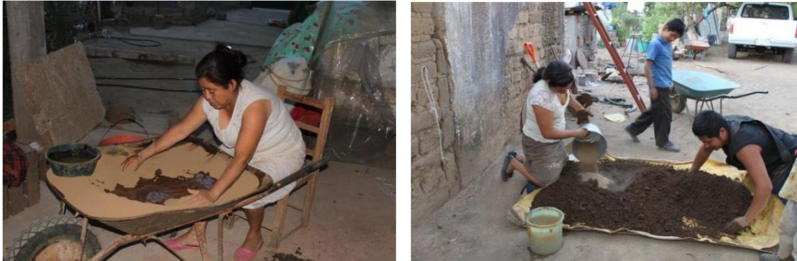
Figura 8. Preparación de la masa de barro sobre una carretilla y en el suelo
