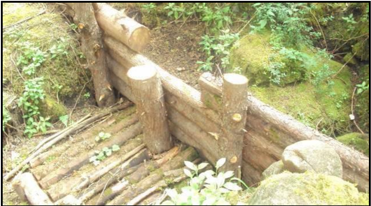
Figura 10. Presa de morillos (Ejido Tequexquihuac)
