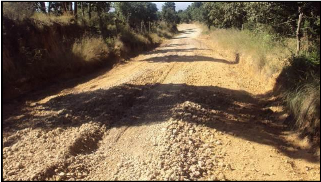
Figura 13. Mantenimiento del camino principal de acceso al bosque
