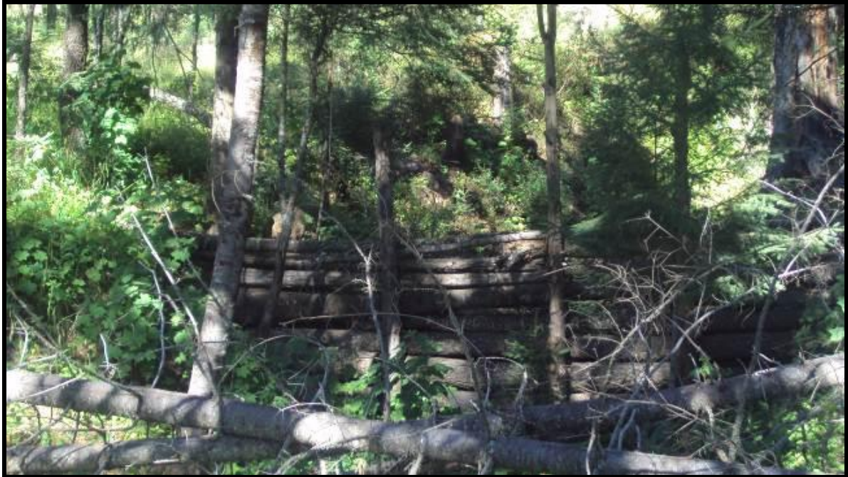
Figura 8. Presa de ramas (Ejido Tequexquinahuac)
