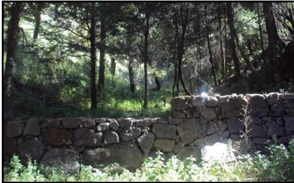
Figura 11. Presa de piedra acomodada (Ejido Tequexquinahuac)
