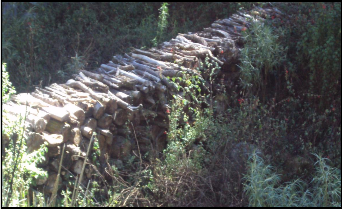
Figura 9. Presa de ramas (Ejido Tequexquahuac)
