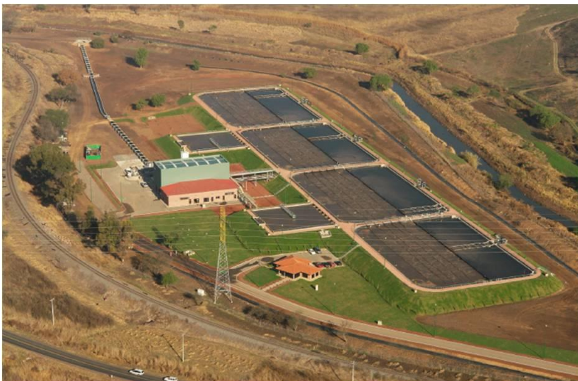
Figura 5.1 Planta de Tratamiento de Aguas Residuales Atapaneo.
