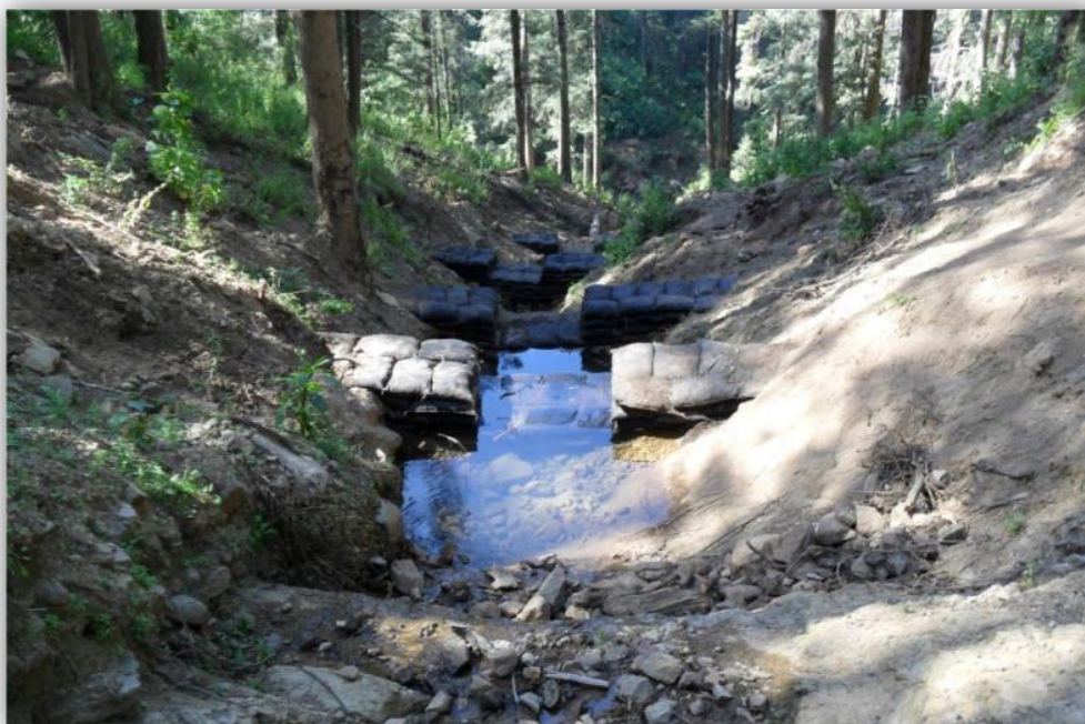
Figura 3.12. Presa de Geocostales
