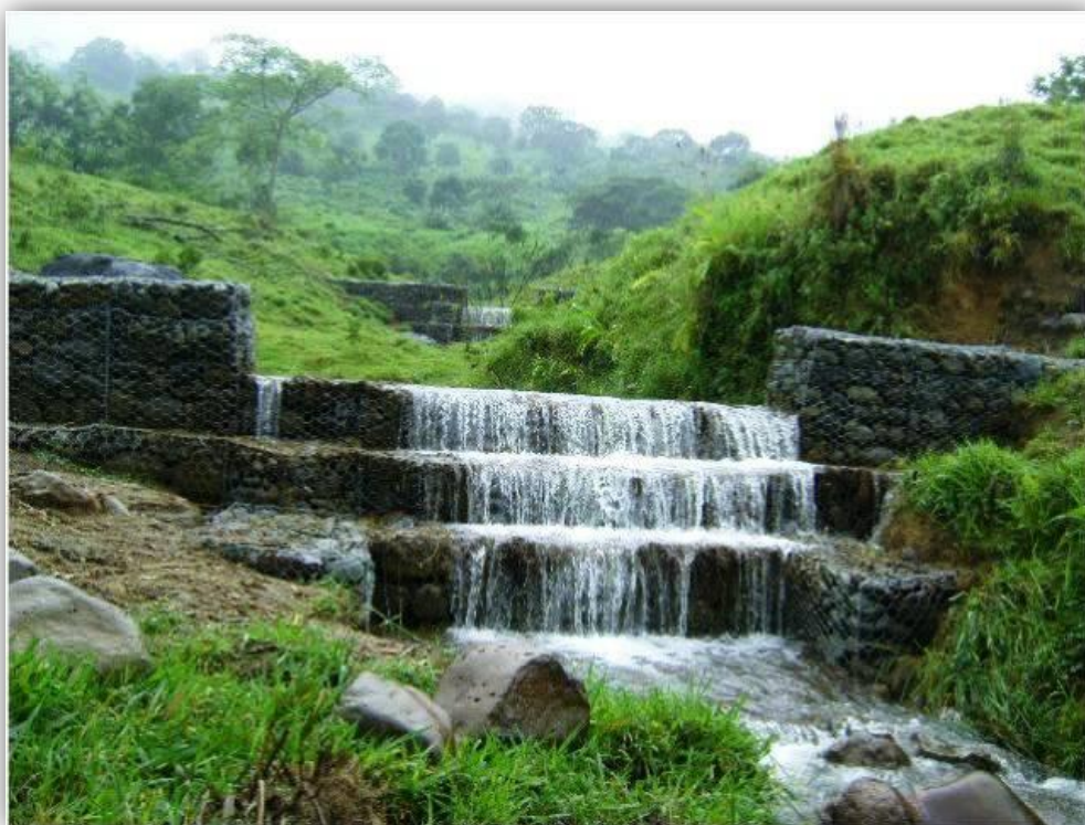
Figura 3.13. Presa de Gaviones
