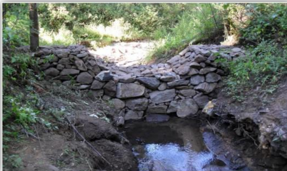
Figura 3.11. Presa de piedra acomodada
