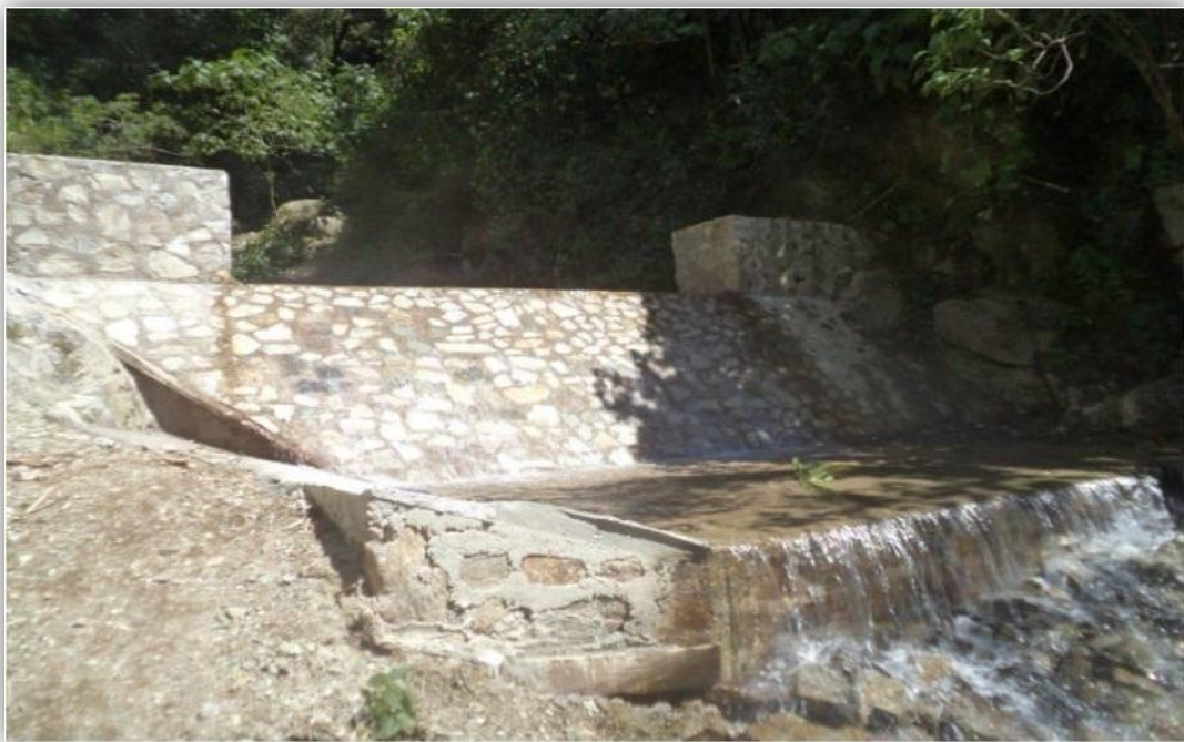
Figura 3.14. Presa de Mampostería
