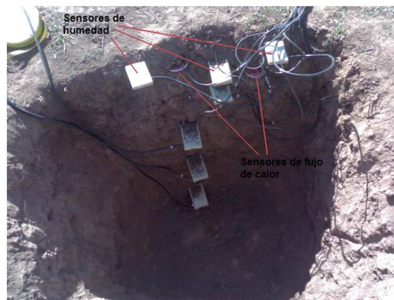
Figura 1-10. Instalación de sensores para la medición del flujo de calor del suelo.
