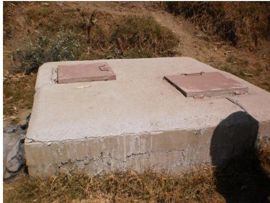
**Foto 5 Caja rompedora de presión (sistema El Salto)**
