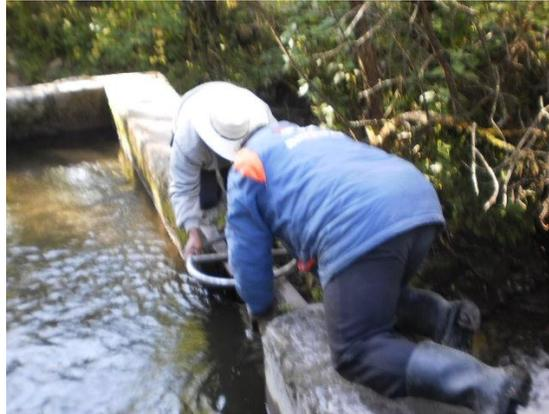
**Foto 14 Faeneros abriendo compuerta para la limpieza de la caja**
