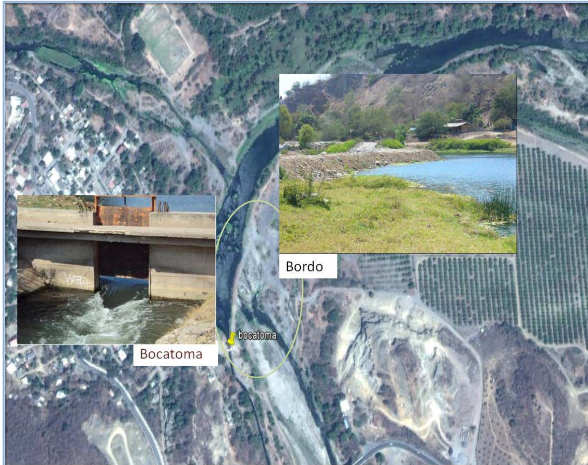
Figura 5.31 Compuerta del dren de unidad de riego y bordo para desviar y captar el recurso
