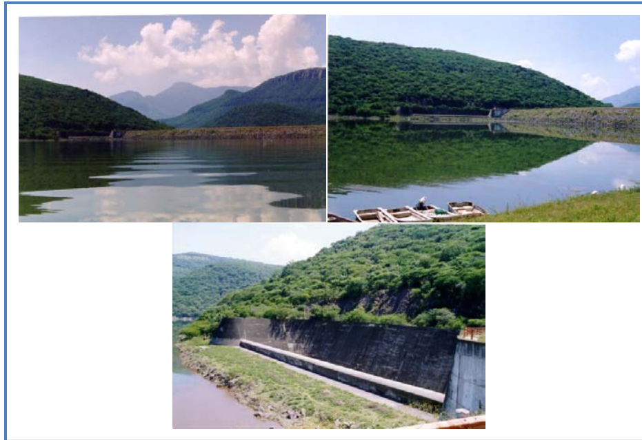
Figura 4.5 Presa Basilio Badillo - Las Piedras, IMTA, 2006
