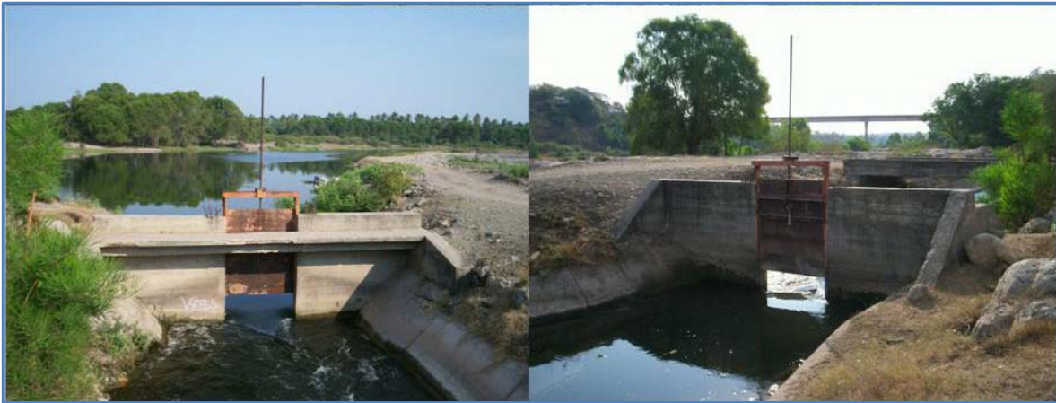
Figura 5.20 Bocatoma en la margen derecha del Río Armería para captar 2 600 Ips
