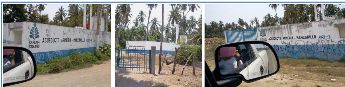
Figura 5.17 Pozos de bombeo del acueducto Armería-Manzanillo
