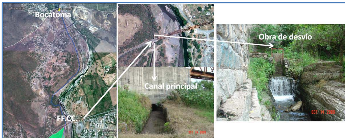
Figura 5.32 Compuerta de desvío para retornar agua al Río Armería
