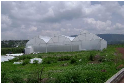
Foto 22. Nave de invernadero.
