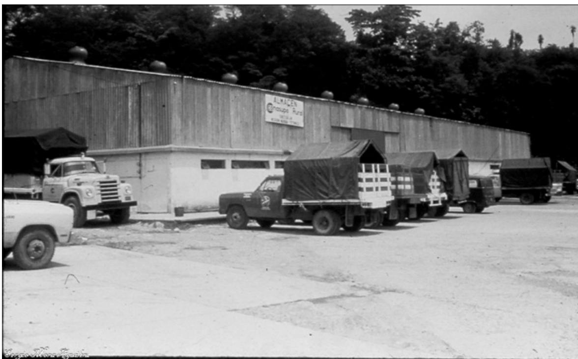
Almacén del Programa CONASUPO –COPLAMAR operado por la CARTT para el abasto de alimentos a través de las tiendas cooperativas comunitarias. Cuetzalan, Puebla, 1982. Archivo fotográfico de Sergio Mora Aguilera.
