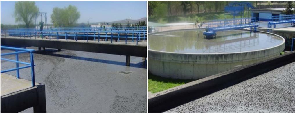
Figura 3.9. Tratamiento de los lodos residuales (digestión aeróbica)
