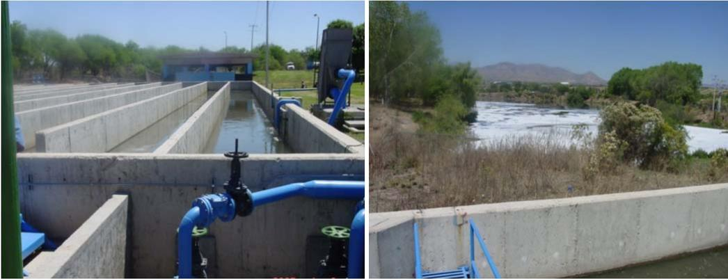
Figura 3.8. Desinfección con cloro del agua tratada
