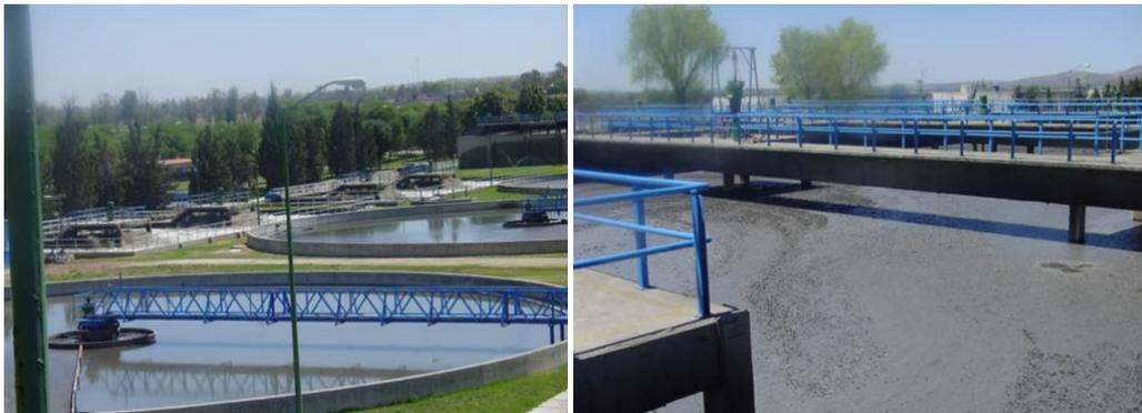
Figura 3.7. Sistema de tratamiento del agua por medio de lodos activados
