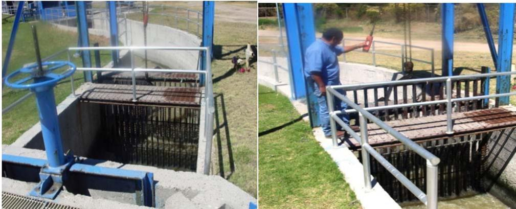
Figura 3.5. Filtración del agua a través de Rejillas de diferente anchura
