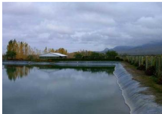
Figura 7. Sistema flexible de almacenamiento: cisterna revestida con geomembrana. Fuente: http://web.uned.ac.cr
