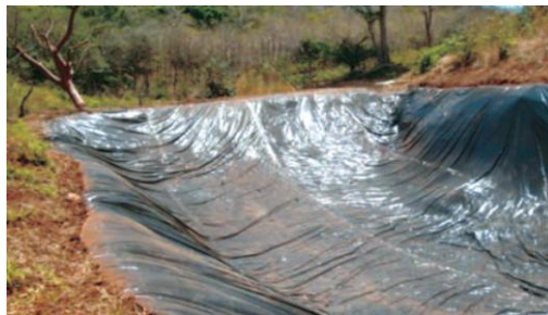
Figura 9. Reservorio dique – represa con revestimiento.
