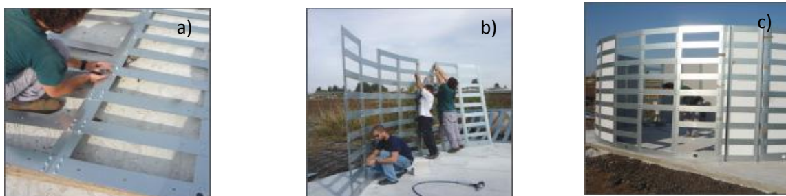
Figura 15. Instalación de depósitos flexibles con paneles. (a) Armado del depósito flexible con malla de acero galvanizada; (b) Levantado de las paredes; (c) Ensamblado de la estructura con los paneles. Fuente: Storage Tank Solutions, 2012.
