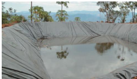
Figura 11. Reservoirio estanque con revestimiento.
