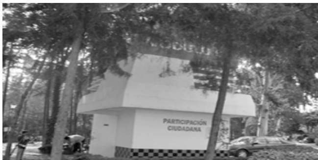
Figura 1.22 Módulo de vigilancia.
