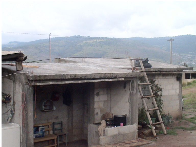
Figura 14. Techos utilizados para la captación del agua de lluvia. San Nicolás Terrenate, Tlaxcala.
