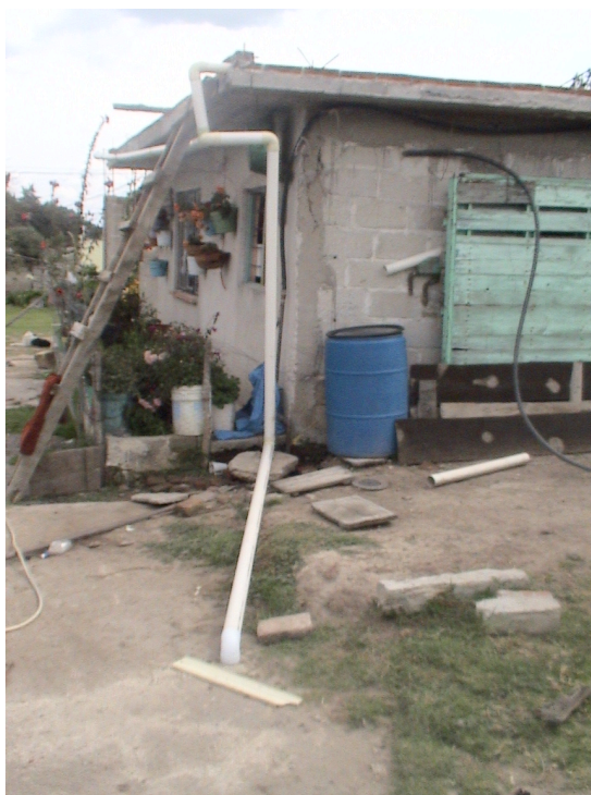
Figura. 13. Componentes del sistema de captación y almacenamiento del agua de lluvia. Españita, Tlaxcala
