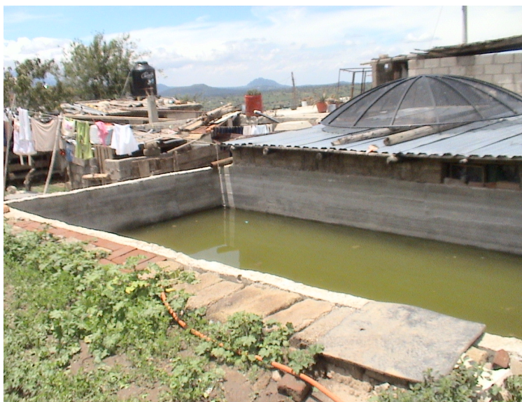
Figura 21. Cisterna de concreto. San Nicolás Terrenate, Tlaxcala.
