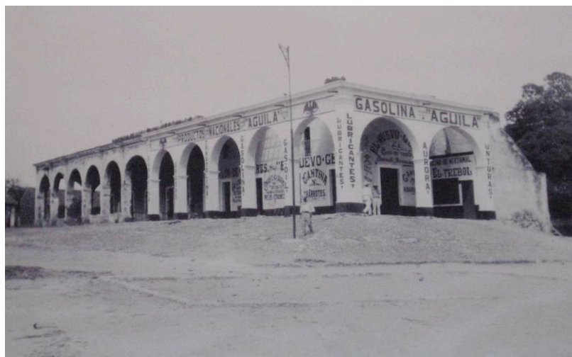
Figura 8. Fachada de los Portales
