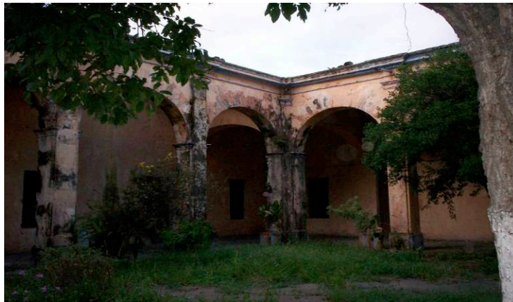
Figura 7. Interior de los Portales
