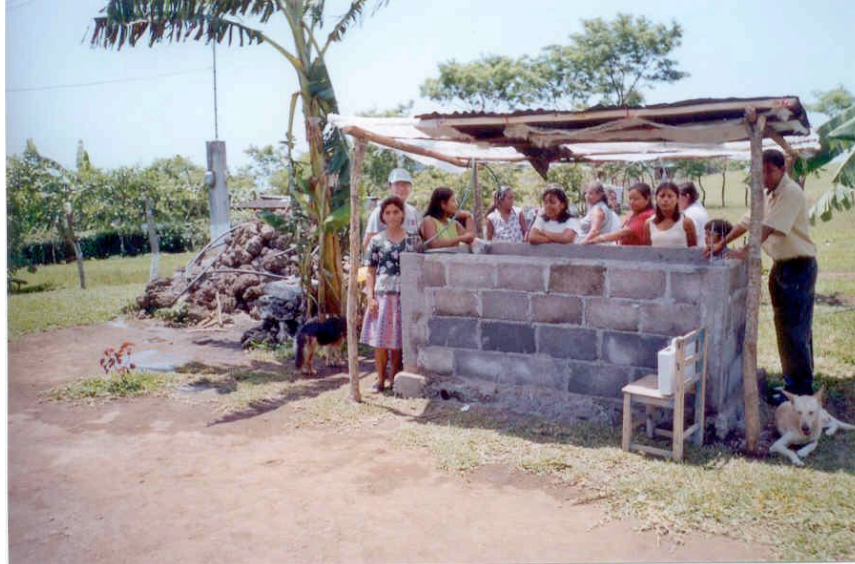
Figura 14. Estanque construido por el grupo de trabajo.
