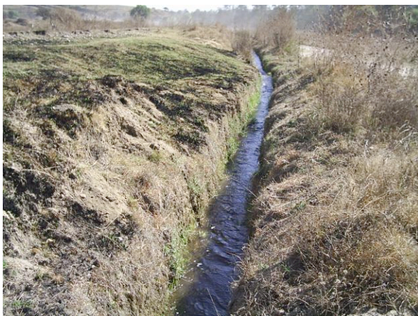
7. Canal Atotonilco (No. 7 IM; No. 7 IIM)
