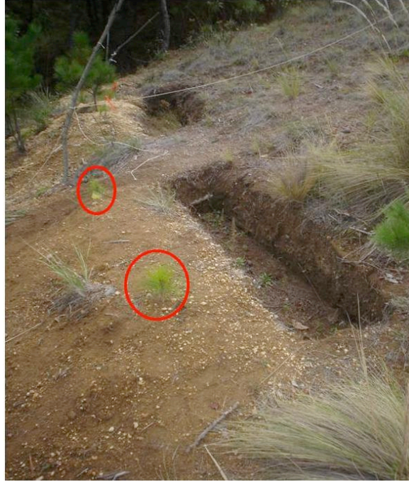
Figura 3.1. Zanja trinchera acompañada de reforestación.
